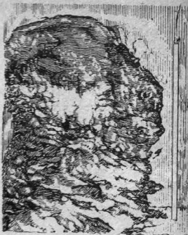
Рис. 142. Вид входной отколыной воронки в бетоне
